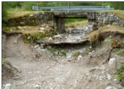
2014, Rio Pozzo località San Francesco: dissesto idrogeologico all'uscita del ponte. A destra lavori ultimati.
