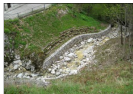
2011-2012, Rio Tacia, sistemazione dell'erosione di sponda.
