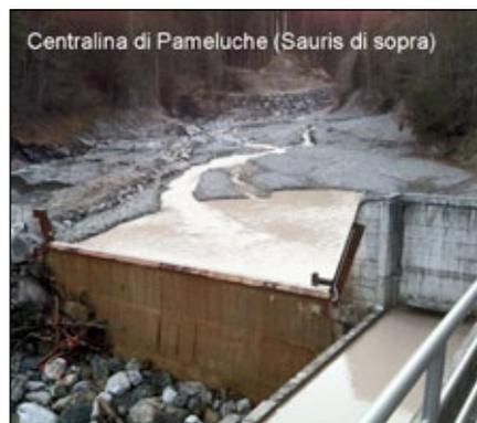
Foto 2: Opera di presa di una centralina idroelettrica costruita recentemente a Sauris di sopra. Si noti l'enorme quantità di ghiaia trattenuta dalla traversa.
